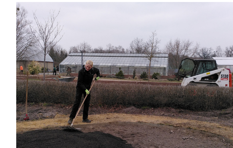
Einbau des Baums substrates | 23.03.2021
